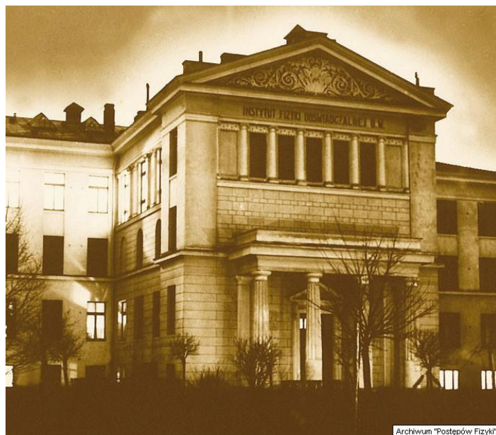
Dawny budynek Instytutu Fizyki UW przy ul. Hożej 69 w Warszawie
