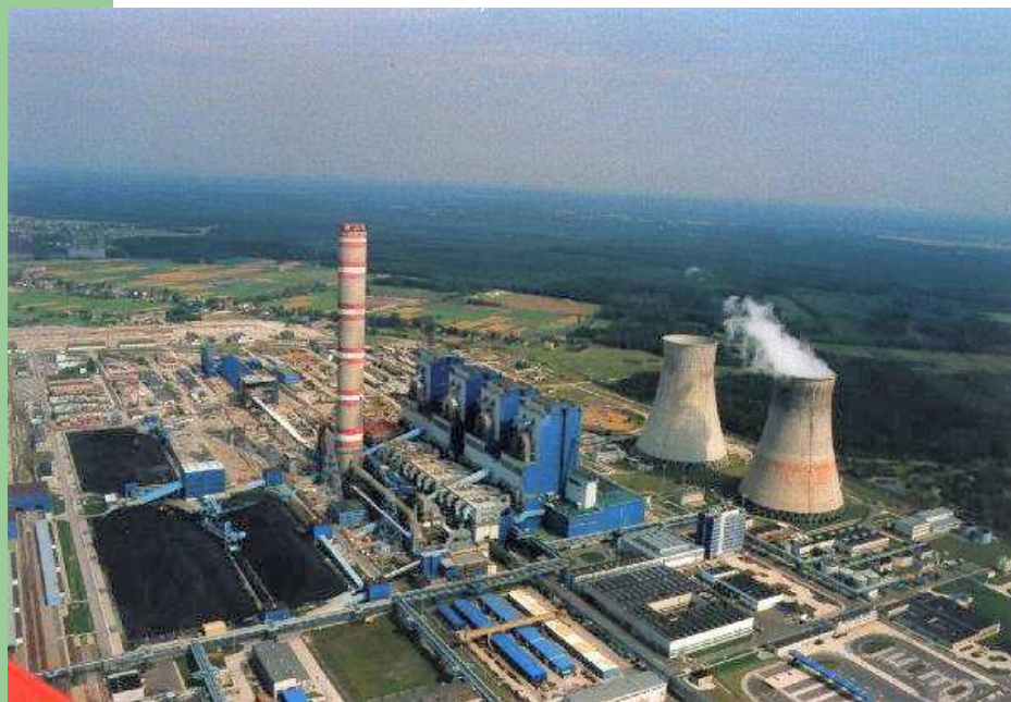
Elektrownia węglowa Opole
