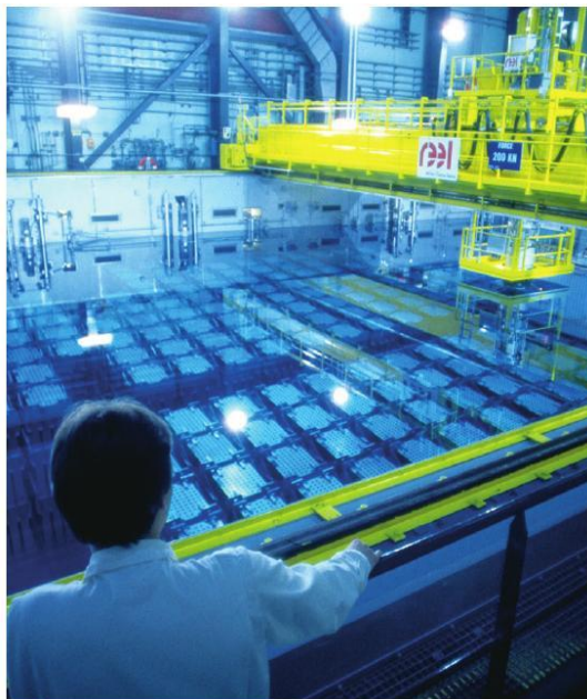
Rys. 6. Basen z pojemnikami do przechowywania zużytego paliwa (All about nuclear energy, AREVA)
