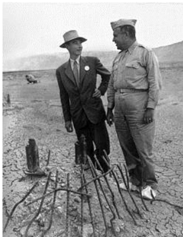
Generał Groves i Oppenheimer na miejscu próbnego wybuchu
