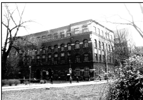
Budynek szkolny (dawna Szkoła Przemysłowa) – róg ul. Krupniczej i Al. Mickiewicza
